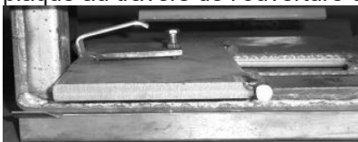
← Retrait de la porte de la voie de dérivation au travers de l'ouverture du catalyseur
